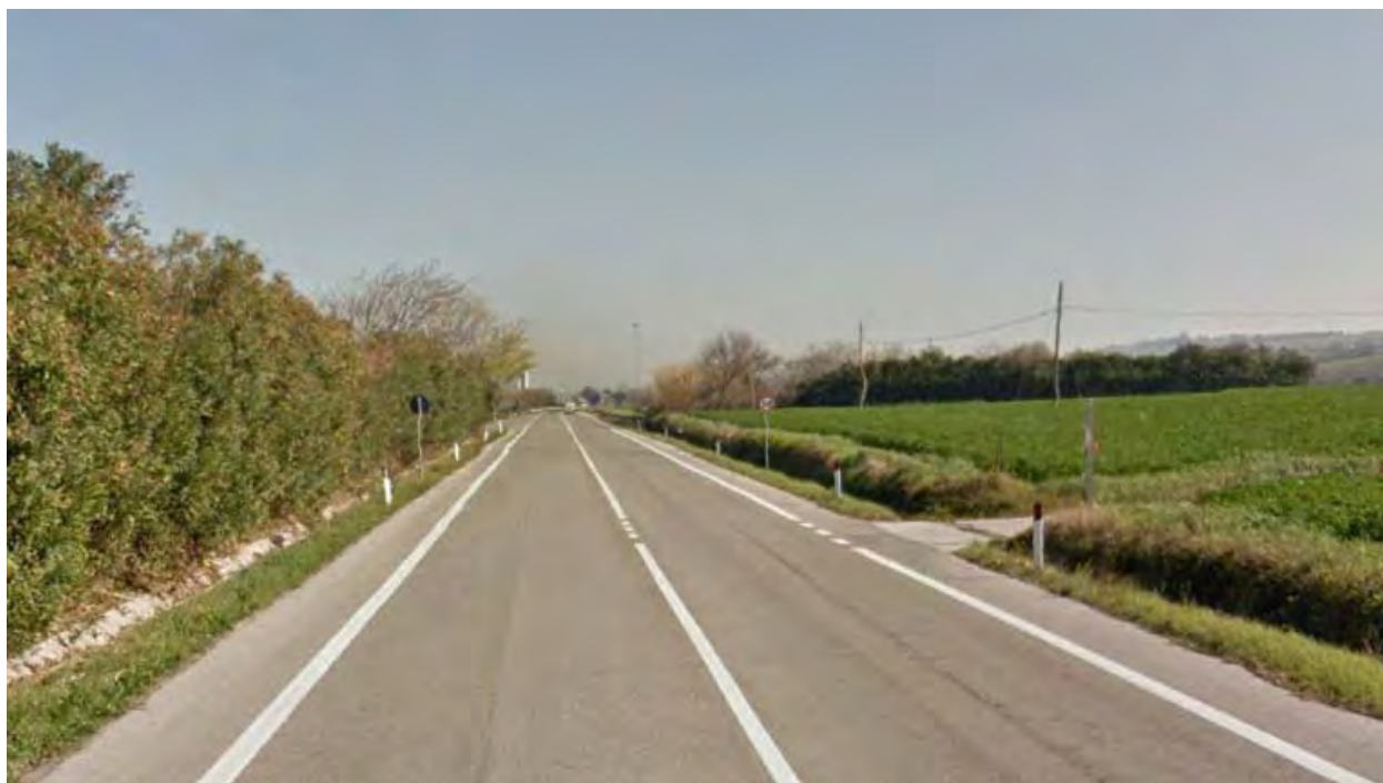
Foto 2: Immagine dalla quale è possibile apprezzare come l'area in variante (a destra della SS16) è posta a quota maggiore del piano stradale della statale adriatica.
